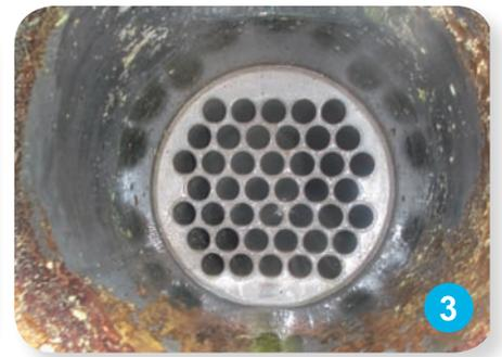
Die **abgasseitige Reinigung** von Abgaswärmetauschern bei Blockheizkraftwerken ist ein wesentlicher Beitrag um die Effizienz des BHKW Motors zu erhalten.
