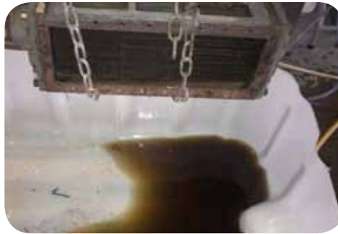
Vor ort wird der Wärmetauscher von Ablagerungen, wie z.B. Korrosionsschlamm, befreit und gesäubert.
